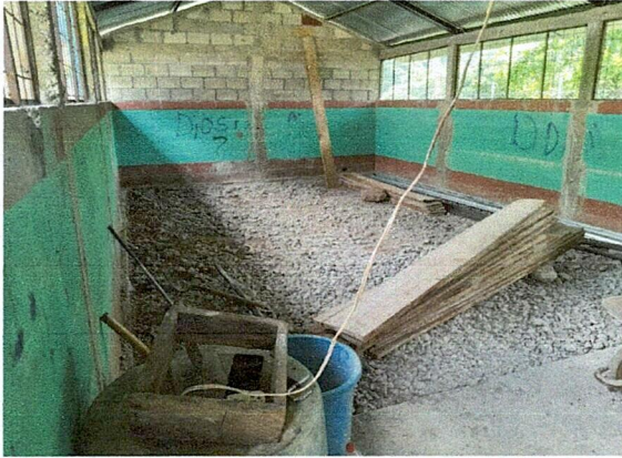
Foto 1: Avance en el renglón de cambio de piso.
