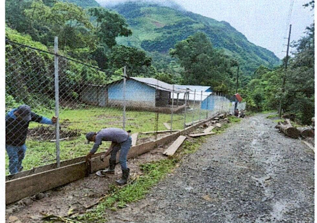
Foto 4: Avance en muro perimetral
