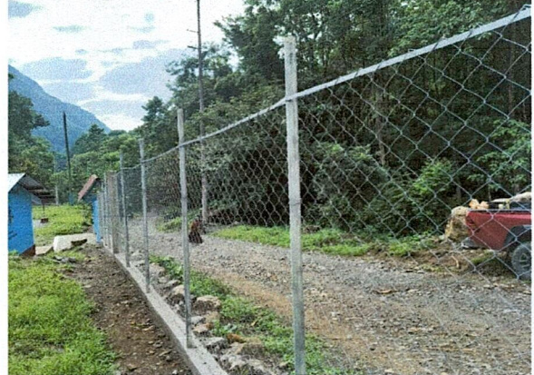
Foto 2: avance en la colocación de muro perimetral
